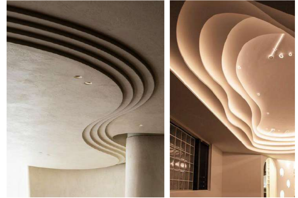
GEBOGENE HÄNGEDECKE mit LED-Beleuchtung
