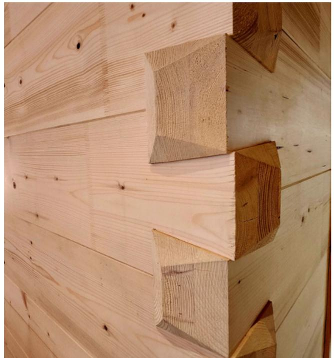
Eine traditionelle «Schwalbenschwanz»-Verbindung der Massivholzbauten
